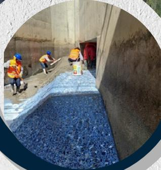
Ejecución del mantenimiento, impermeabilización y limpieza de los hastiales laterales, pisos y losas de los canales, túneles de conducción y todo tipo de estructuras, tratamiento de juntas de dilatación y construcción, reparación del desgaste de los recubrimientos de las estructuras con soluciones rápidas, con la finalidad de mejorar su superficie.
