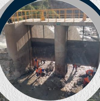
Efectuamos la remoción periódica o inmediata de materiales como lodo, arena y material de río, para facilitar el proceso de desarenado o descolmatación de las estructuras de captación, bocatoma, canales y desarenadores. Asimismo la reconstrucción y construcción de enrocados y defensas para la protección de bocatomas.
