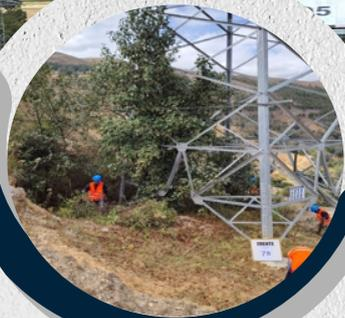
Realizamos la limpieza y/o remodelación de los drenajes y cunetas de coronación en suelo natural de las estructuras de la Línea de Transmisión. El proceso implica la erradicación de impedimentos que dificultan el acceso a las estructuras.
